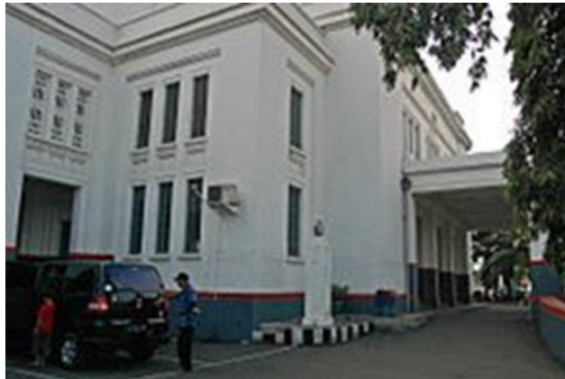
Gambar 2. Pintu Masuk Bangunan Sumber: Data Pribadi, 2018
