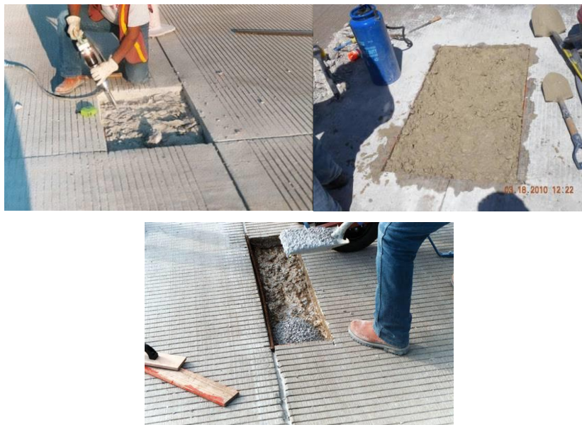
Gambar 4.1. Foto Perbaikan Partial Depth Repair Sumber : Penelitian Mandiri
